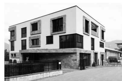
2016 Ristrutturazione e ampliamento della sede principale ad Appiano. Umbau und Erweiterung des Hauptsitzes in Eppan. Renovation and expansion of the headquarters in Appiano.
