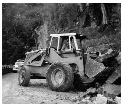
1961 Inaugurazione della prima cava aziendale di porfido in Alto Adige. Fornitura della costruzione di muri di sostegno dell'autostrada del Brennero. Eröffnung des ersten firmeneigenen Porphyrsteinbruches in Südtirol. Belieferung des Baus von Stützmauern der Brennerautobahn. Opening of the first corporate quarry of porphyry in Alto Adige. Supply of the construction of supporting walls for the motorway Brennero.
